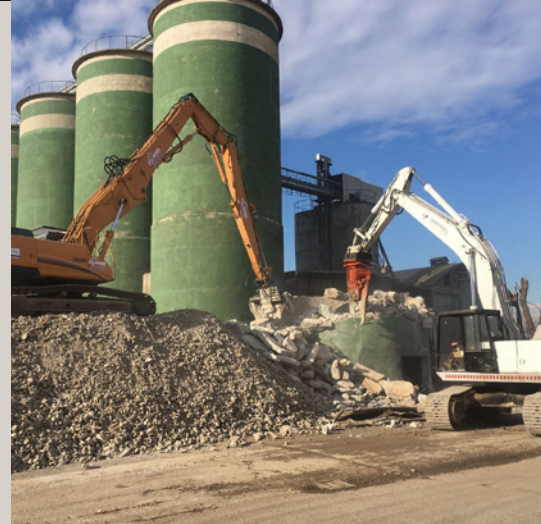
Demolizione sylos, forni e separazione refrattari
